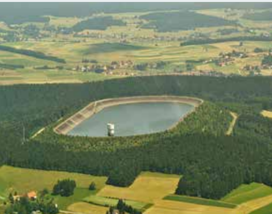
Das Speicherbecken des Pumpspeicherkraftwerks Wehr im Hotzenwald. Quelle: http://www.schluchseewerk.de
