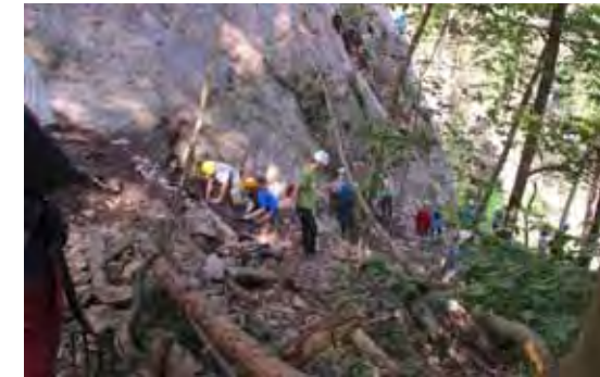
Ein neuer Weg entsteht am Wandfuss der Felsen!
